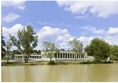
Le pôle aqualudique du Païcherou est implanté dans un méandre de l'Aude en contrebas de la ville.
