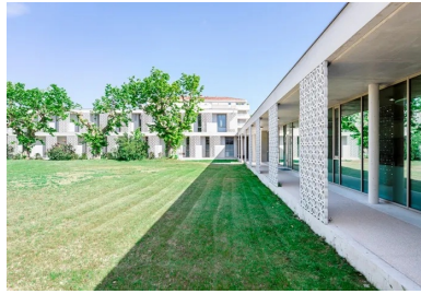
Les différents bâtiments de l'institution sont desservis par des coursives extérieures. Celles-ci sont bordées et ponctuées par les mêmes éléments de panneaux de façade ajourés en béton fibré.
