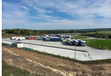
Une aire de repos en béton de 20 000 m 2 . (© Gilles Petit /DIRA)
