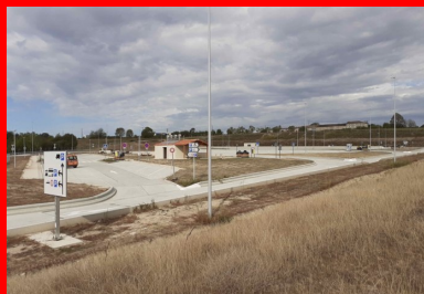
Vue générale de l'aire de repos de la Grolle achevée. (© Gilles Petit_DIRA)
