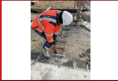
Fixation des paniers de goudjons sur la grave-bitume. (© Joseph Abdo_JA-Consulting)
