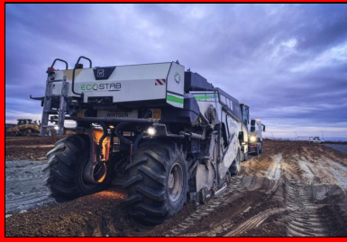
Malaxage du matériau de la couche de forme avec le liant hydraulique routier Ligex. (© D. Daguzan_Ecostab)
