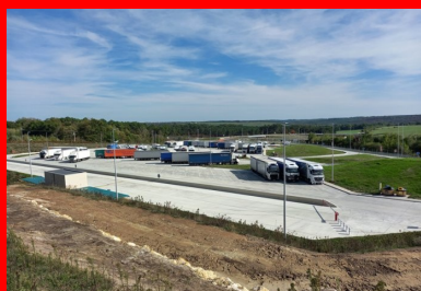
Une aire de repos en béton de 20 000 m 2 . (© Gilles Petit /DIRA)
