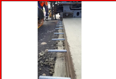
Insertion des goujons à mi-hauteur sur les deux flancs de la bande en béton. (© Luc Lefol, Eurovia)
