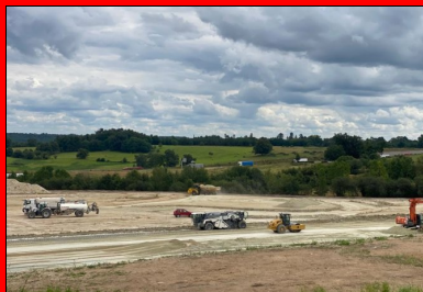
Vue de l'atelier de traitement du sol en place au liant LIGEX avec, au premier plan, un compacteur à bille lisse en action. (© D. Daguzan_Ecostab)
