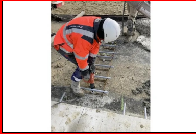
Fixation des paniers de goudrons sur la grave-bitume. (© Joseph Abdo_JA-Consulting)
