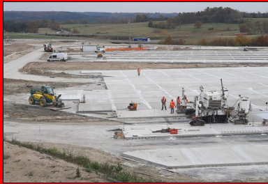
Quand elle progresse en clivage, la machine prend comme référence la hauteur des bandes existantes situées de part et d'autre. Le guidage en direction est donné par un fil. (© Luc Lefol, Eurovia)
