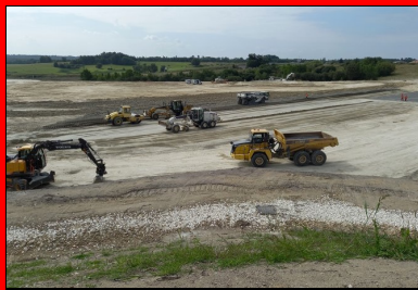
Vue générale de l'atelier de traitement de la couche de forme au LHR Ligex. (© Gilles Petit_DIRA)
