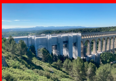
Les travaux portent notamment sur le remplacement des pierres et la réflexion de l'étanchéité sur les trois tabliers.
