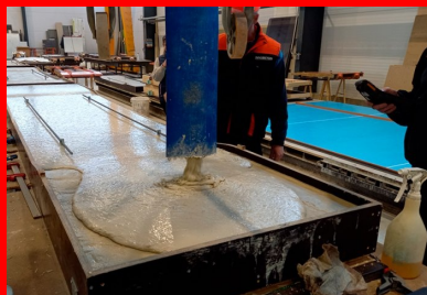
Préfabrication des dalles. Le BFUP est coulé dans des moules en polyuréthane.
