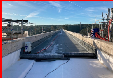
Etanchéité du tablier supérieur : les dalles en BFUP vont recouvrir la géomembrane pour la lester.
