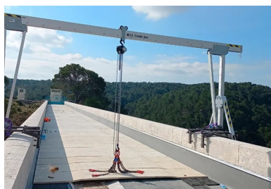
Les dalles manipulables sont posées à l'aide d'un portique roulant.
