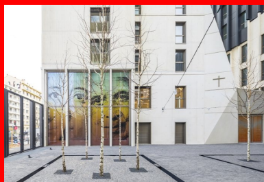
Des œuvres sérigraphiques placées en façade signalent la présence du centre diocésain.
