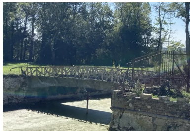
Pont de Chazelet 1
