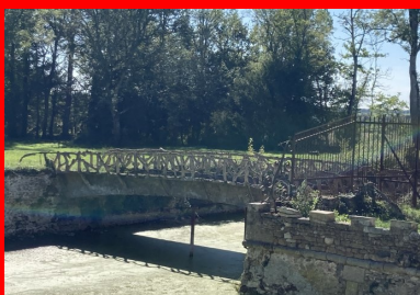
Pont de Chazelet 1
