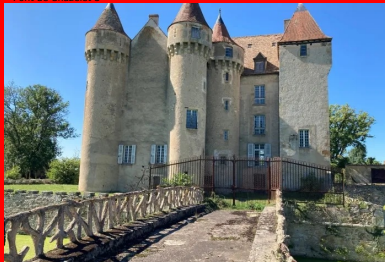
Pont de Chazelet 4
