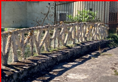
Pont de Chazelet 5
