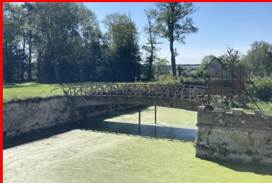
Pont de Chazelet 2
