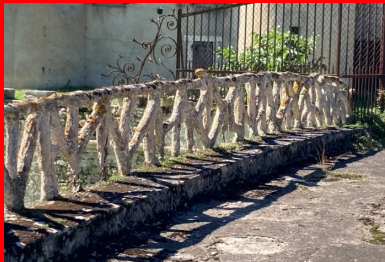
Pont de Chazelet 5
