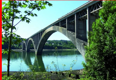
L'ouvrage, aujourd'hui toujours debout, est considéré comme un héritage somptueux de l'âge d'or du béton armé. © Coll. Ville de Landerneau ; Photothèque, Association Eugène Freyssinet
