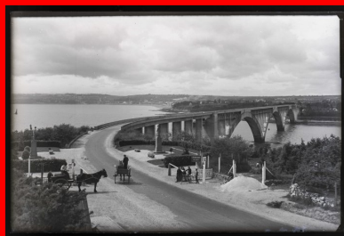
Jusqu'en 1994, année de mise en service du pont voisin de l'Iroise, le pont Albert-Louppe permettait la traversée des voitures automobiles...ou à cheval ! © Coll. Ville de Lanterneau ; Photothèque, Association Eugène Freyssinet
