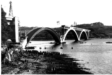
Reconstruction de l'une des arches, démolie pendant la seconde guerre mondiale, à l'aide d'un cintre similaire au cintre d'origine. © Coll. Ville de Landerneau ; Photothèque, Association Eugène Freyssinet
