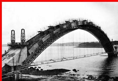
Bétonnage par plots du premier arc. © Coll. Ville de Landerneau ; Photothèque, Association Eugène Freyssinet
