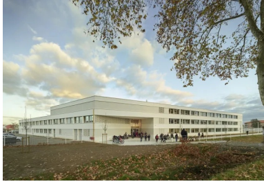
La partie la plus élevée du bâtiment (R+2) se dresse sur la route de Paris et affiche la présence de l'institution scolaire. @ Roland Halbe
