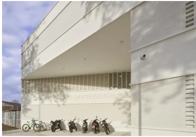
À l'angle, un mur, sur lequel est imprimé en creux le nom de l'établissement, conduit vers l'entrée du collège et du lycée. @ Roland Halbe
