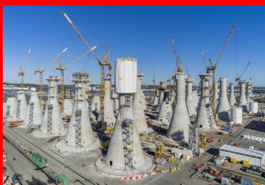
Pour optimiser le processus industriel de construction, les embases étaient réalisées en décalage de phases.
