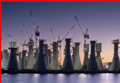
Les 71 fondations gravitaires ont été érigées en parallèle sur un quai du grand port maritime du Havre.
