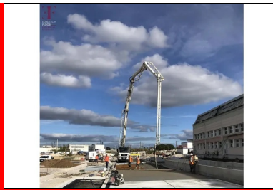
Bétonnage à la pompe et serrage du béton à l'aide d'un rouleau Striker.
