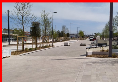
L'aménagement de la grande place Rivierre-Cassils respecte un équilibre minéral-végétal et fait appel à des matériaux clairs pavés et dalles calcaires et béton égrésé.
