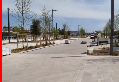
L'aménagement de la grande place Rivière-Cassils respecte un équilibre minéral-végétal et fait appel à des matériaux clairs pavés et dalles calcaires et béton égrésé.
