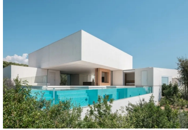
Villa SI – Résidence secondaire. L'espace du séjour s'ouvre en angle sur l'extérieur.
