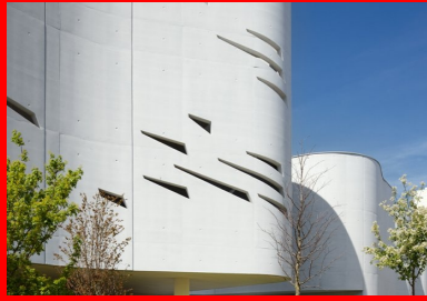
Les façades béton sont griffées de petites percées qui apportent un éclairage naturel sans dévoiler.
