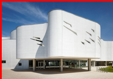
Côté parvis et entrée principale, un large encorbellement protège les façades vitrées des rayons solaires.
