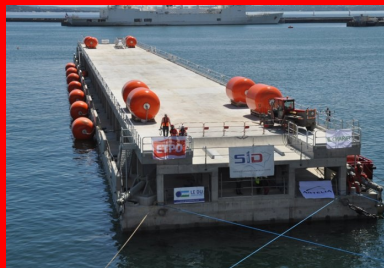
Le ponton flottant dispose de deux ponts superposés. Le pont supérieur est dégagé de toute servitude technique pour rester accessible en permanence aux opérations de chargement/déchargement.
