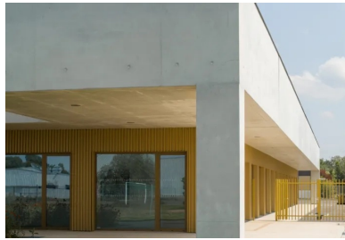
Sur les quatre côtés, les débords de toiture permettent de protéger du soleil les espaces de travail de la cuisine centrale et les salles de restauration, qui peuvent ainsi bénéficier de larges vitrages.
