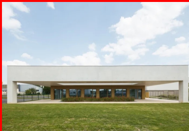
L'attique et les quatre poteaux d'angle dessinent comme une table en béton clair, sous laquelle s'organise en retrait, l'ensemble du programme.
