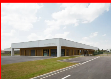
Les aires de manœuvre de la cuisine centrale se trouvent en façade est et nord, proches de l'accès au site.
