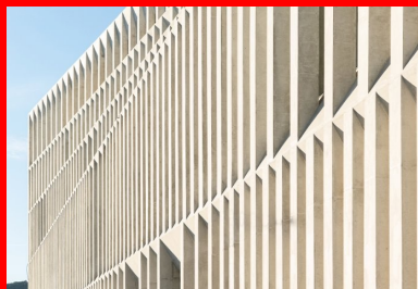
Détail de la façade sud en béton architectonique avec parement laissé brut de décoffrage.
