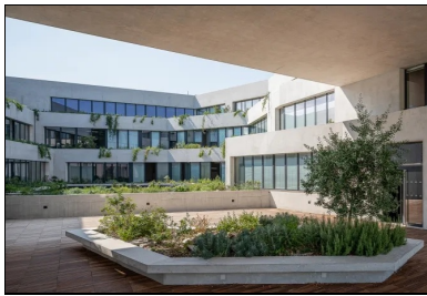
Vue intérieure depuis la terrasse du R+1.
