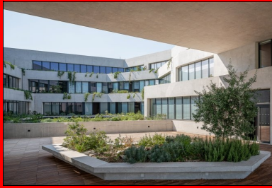
Vue intérieure depuis la terrasse du R+1.
