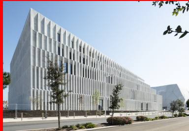
Façade sud - entrée ouest de la ville de Cannes depuis l'aéroport de Cannes-Mandelieu.
