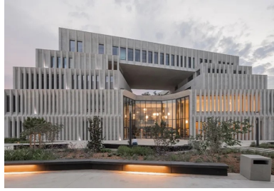
Façade ouest - entrée principale du campus Georges Méliès.
