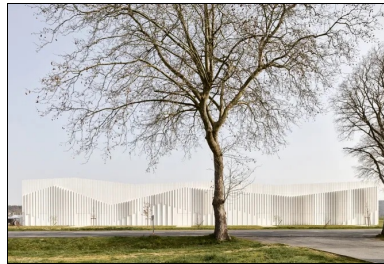
Les façades de la salle sont réalisées avec des panneaux préfabriqués en béton blanc de type mur à coffrage intégré (MCI), qui assurent de façon performante la protection acoustique de l'environnement extérieur.
