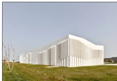
La salle se perçoit comme un monolithe en béton blanc, mat et texturé qui joue avec les ombres.
