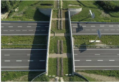
Vue aérienne du passage à faune de Moirans, sur l'A48. © Romain Courtaud
