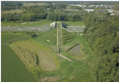
L'aménagement de l'ouvrage reproduit l'écosystème environnant pour compenser l'effet de rupture généré par l'infrastructure. © Romain Courtaud
