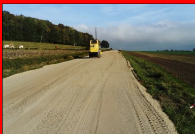
Mise en œuvre de la couche d'assise en gravier non traité.
