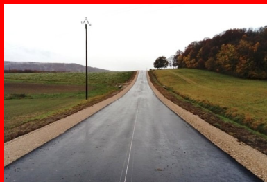
Réhabilitation de la RD25 achevée. Accotement réhaussé et axe de prémarquage réalisé.
