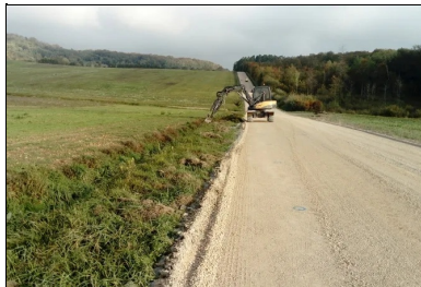
Réalisation des fossés latéraux.
