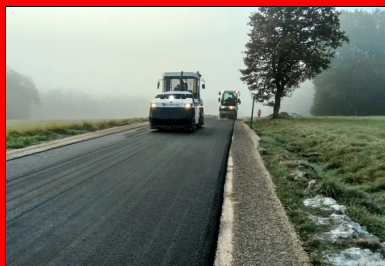
Atelier de compactage du BBGS.
