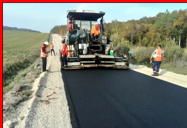
Mise en œuvre de la couche de surface en BBGS à l'aide d'un finisseur.
