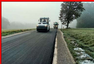
Atelier de compactage du BBGS.
