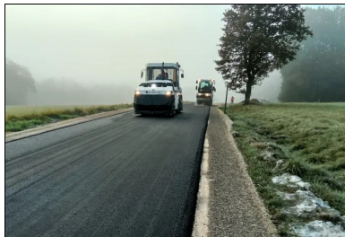
Atelier de compactage du BBCS.
