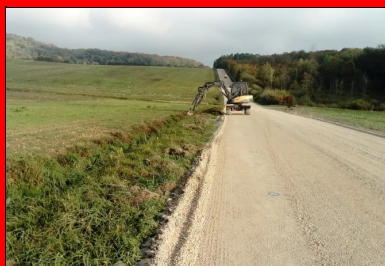
Réalisation des fossés latéraux.
