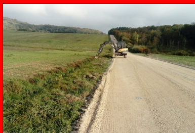
Réalisation des fossés latéraux.
