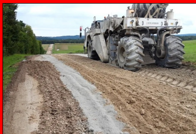
Après l'épandage du LHR, le malaxeur entre en action pour mélanger le matériau et le liant.
