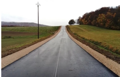
Réhabilitation de la RD25 achevée. Accotement rehaussé et axe de prémarquage réalisé.
