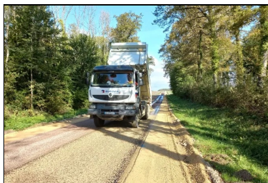
Mise en œuvre de l'enduit superficiel de protection.
