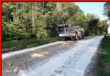
Après l'épandage du LHR, le malaxeur entre en action pour mélanger le matériau et le liant.
