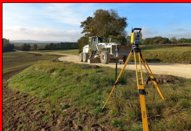
Mise en œuvre de la couche d'assise en grave non traitée.
