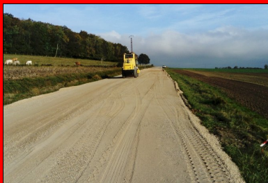
Mise en œuvre de la couche d'assise en grave non traitée.
