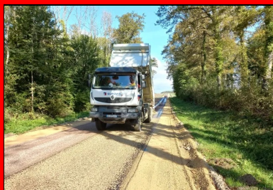
Mise en œuvre de l'enduit superficiel de protection.
