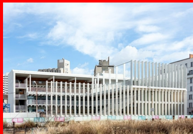
Côté mer, les écoles superposées et leurs cours au 1 er et au R+2 s'ouvrent sur le paysage à travers le rythme de la colonnade, à la fois protectrice et poreuse.
