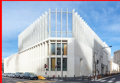
Sur la rue Antoine de Ruffi, la colonnade de poteaux hexagonaux en béton vient encadrer les deux cours de récréation et offre une protection solaire performante pour les expositions est et ouest.
