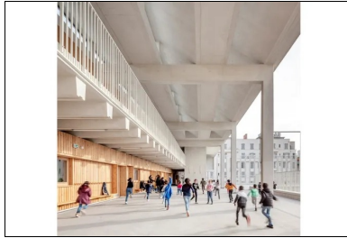
Vue du préau double hauteur.
