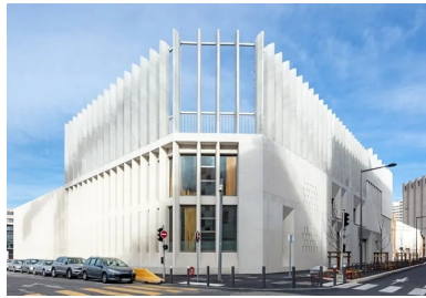
Sur la rue Antoine de Ruffi, la colonnade de poteaux hexagonaux en béton vient enclore les deux cours de récréation et offre une protection solaire performante pour les expositions est et ouest.
