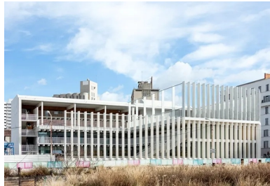
Côté mer, les écoles superposées et leurs cours au rdz et au R+2 s'ouvrent sur le paysage à travers le rythme de la colonnade, à la fois protectrice et poreuse.
