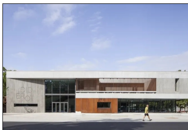
Les façades en béton brut déclinent une composition de bandeaux horizontaux au parement lisse et de parois texturées à la planche, que viennent ponctuer des éléments en acier Corten et les grandes baies vitrées.
