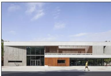
Les façades en béton brut déclinent une composition de bandeaux horizontaux au parement lisse et de parois texturées à la planche, que viennent ponctuer des éléments en acier Corten et les grandes baies vitrées.
