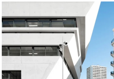
L'angle extérieur qui fait face à la gare s'infléchit pour marquer l'entrée dans le nouveau quartier.
