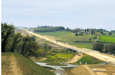
Déviation de Gimont : une couche de forme traitée au LHR
