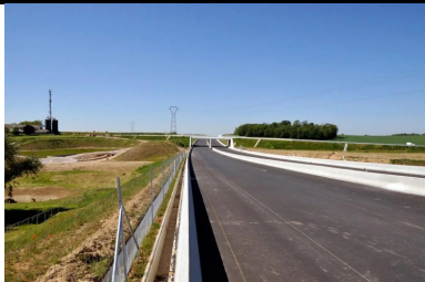
Traitement des loess et des lehms pour les travaux de terrassements du contournement ouest de Strasbourg
