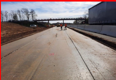
Contrôle du compactage au gamma-densimètre.
