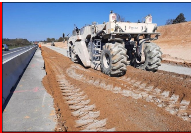
Malaxage à l'aide d'un pulvimixeur.
