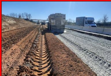
Les matériaux issus des déblais ont été répandus sur le site à l'aide d'une niveleuse, sur une épaisseur homogène. Puis un épandeur asservi a procédé à l'épandage du LHR Ligex M4.
