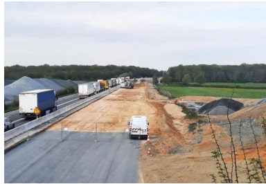
Vue générale du chantier de mise à 2x2 voies de la RN79 entre toulon-sur-allier et digoin.
