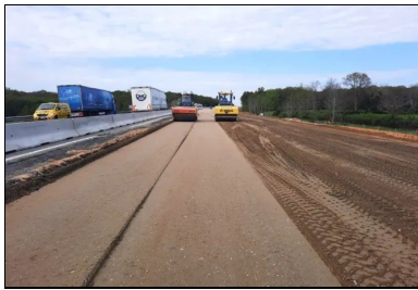
Compaction à l'aide de compacteurs à bille lisse.
