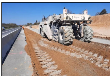
Malaxage à l'aide d'un pulvimixeur.
