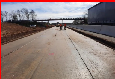
Contrôle du compactage au gamma-densimètre.
