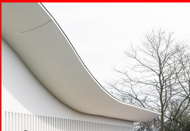
Des failles verticales marquent l'épaisseur de la façade ouest. Le béton de teinte blanche participe de la régulation thermique du bâtiment.
