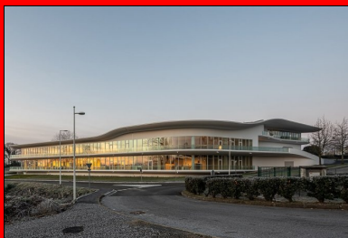
Façades nord et est entièrement vitrées offrent aux salles attenantes un accès direct aux coursives.
