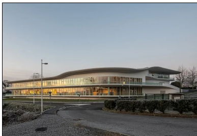
Façades nord et est entièrement vitrées offrent aux salles attenantes un accès direct aux coursives.
