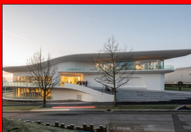
Entre rez-de-jardin et premier étage, l'accès à l'entrée principale par une rampe suit la topographie du site.
