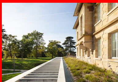
Seul témoin de la présence d'une construction semi-enterrée, le claustra de béton qui ceinture l'extension.
