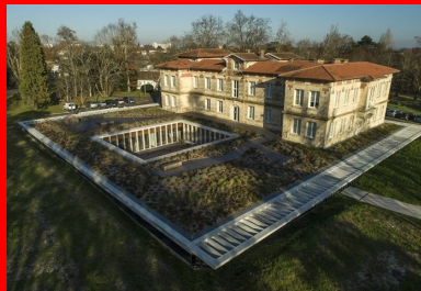
Avec sa toiture végétalisée, l'extension semi-enterrée se fond dans le parc paysager.
