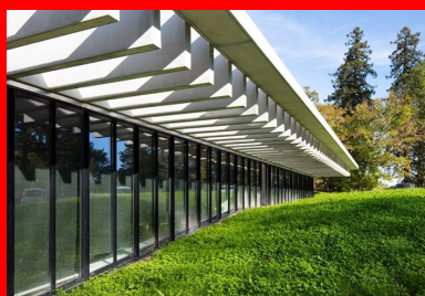
Les modelés de terrain permettent aux locaux de bénéficier de lumière naturelle en préservant l'intimité des occupants.
