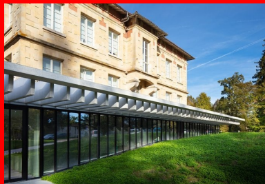
Posées en porte-à-faux, les lamelles de béton de la corolle périphérique protègent la façade vitrée des rayons solaires.
