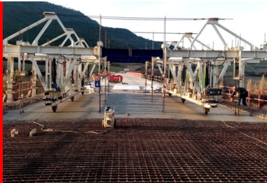
Bétonnage d'un plot de hourdis supérieur à l'aide d'un équipement mobile. Le bétonnage est réalisé par « pianotage », afin de répartir les charges de manière homogène. ©DIR Med
