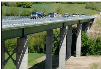
Épreuves de chargement du viaduc. Cette étape classique et obligatoire de la construction d'un ouvrage d'art consiste à vérifier que celui-ci est bien apte à assurer sa destination finale en termes de portance. Pour cela, un certain nombre de camions, dont le poids et la répartition sont calibrés, sont positionnés sur le tablier. Les flèches induites sur le tablier sont alors mesurées et comparées aux flèches théoriques attendues. ©DREAL Occitanie
