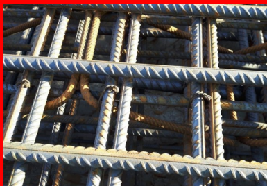
Ferrailage du hourdis inférieur. La densité d'armatures de cette dalle est très importante (environ 300 kg/m 3 , contre 250 kg/m 3 pour le hourdis supérieur). ©DIR Med
