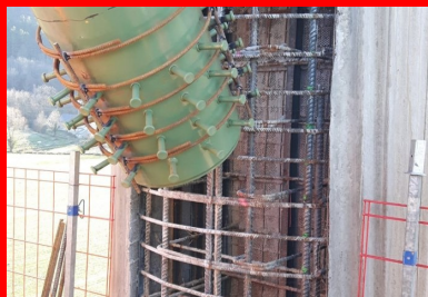
Clavage des entretoises des piles avec les fûts. Des réservations sont réalisées dans les fûts au droit de la jonction avec les extrémités des croix métalliques. Un ferrillage (non visible sur la photo) reliant les deux éléments est mis en place avant de couler le béton qui formera les bossages (visibles sur la photo n° 6). ©CEREMA
