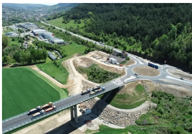
Vue aérienne de la culée CO. Le viaduc du Lot est l'ouvrage d'art principal de la future rocade ouest de Mende (en arrière-plan, le centre-ville). ©DREAL Occitanie
