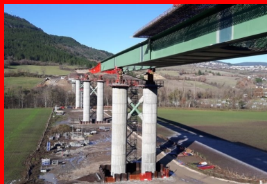
Lancement de la charpente. D'abord assemblé sur une plateforme installée sur l'une des deux culées de l'ouvrage, le tablier a été mis en place au cours de huit lancements successifs, muni d'une partie du ferrillage du hourdis supérieur ainsi que des prédalles et du ferrillage du hourdis inférieur. ©CEREMA
