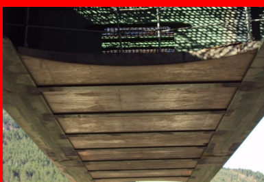
Prédalles participantes du hordis inférieur - phase de lancement de la charpente. Mises en place avant le lancement, elles servent de fond de coffrage lors du coulage du hordis inférieur. ©CEREMA
