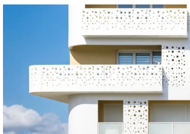
Des panneaux préfabriqués en béton perforés de trous de différents diamètres viennent au niveau des balcons et des loggias. Ils jouent un rôle de filtre et préservent l'intimité des logements.
