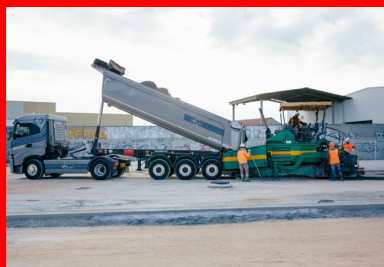
Un camion-benne, bâché, durant le transport du BCR, déverse le matériau dans le finisseur. Celui-ci répand, nivelle et compacte le BCR.
