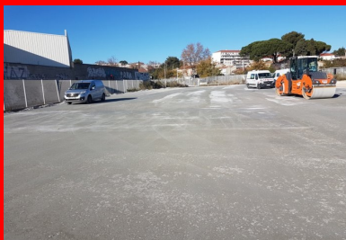
Le BCR acquiert rapidement une stabilité structurelle autorisant le stationnement des véhicules légers (© Colas)
