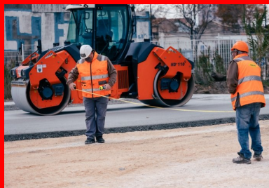
Pendant que la première couche de la première bande de BCR est compactée par un VT2, l'entreprise effectue les mesures pour positionner une nouvelle bande en respectant le plan de bétonnage en peigne. (© Béton Vicat)
