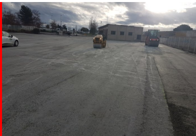
Compactage du BCR à l'aide de deux compacteurs vibrants VT2 et PV2. (© Colas)
