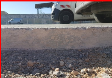
Pour la reprise de bétonnage, le joint de construction est scié proprement sur toute l'épaisseur de la couche de BCR puis humidifié. On voit bien la qualité de compactage (homogénéité et compacité) obtenue sur toute la hauteur de la couche. (© Colas)
