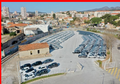
Vue aérienne de la plate-forme de stockage des véhicules en transit sur le Port de Brégaillon. (© Béton Vicat)
