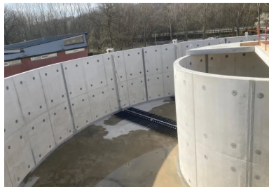
Les voiles des bassins ont été réalisés à l'aide d'un outil coffrant circulaire fabriqué sur mesure. Les rayons de courbure de chacun des bassins étant différents, le coffrage était réglé pour épouser précisément les courbes.
