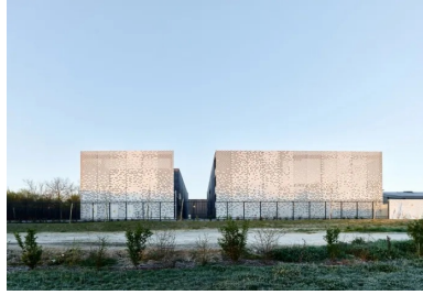
L'enveloppe de l'ouvrage est réalisée avec des panneaux préfabriqués blancs en béton fibré à ultra haute performance.
