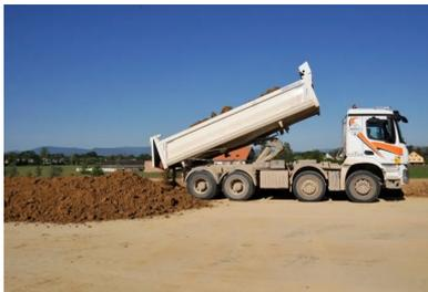
Acheminement des matériaux depuis le dépôt provisoire et mise en place sur site pour une épaisseur finale de 35 cm.
