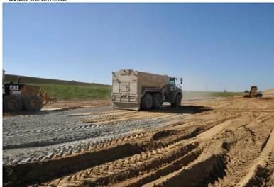
Après scarification, épanchage du liant hydraulique routier.
