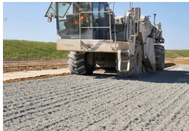
Un liant spécifique (ROC COS) a été développé par EQIOM en lien avec les équipes du projet, puis livré entre 2019 et 2021 en fonction des phasages du projet.
