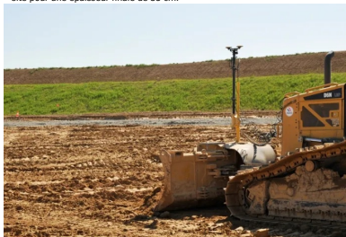
Préréglage à l'aide d'un bull asservi GPS afin d'obtenir une épaisseur homogène avant traitement.
