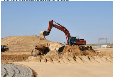
Les techniques utilisées ont permis le ré-emploi de la majorité des déblais du chantier afin de préserver les gisements locaux.
