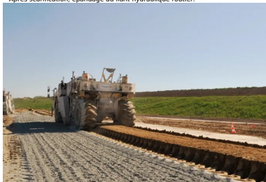
Malaxage du matériau avec le LHR par un malaxeur Wirtgen.
