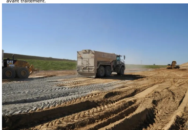
Après scarification, épanchage du liant hydraulique routier.
