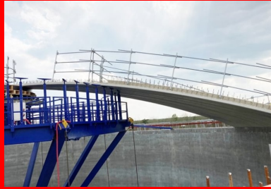
Chaque pétale est équipée de garde-corps de chantier avant d'être positionnée sur l'outil-parapluie.
