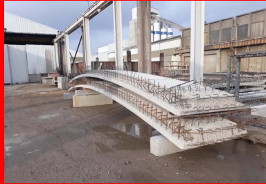
Pour réaliser les 638 pétales qui couvrent les 11 digesteurs, la préfabrication a été privilégiée.
