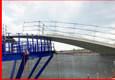
Chaque pétale est équipé de garde-corps de chantier avant d'être positionné sur l'outil-parapluie.
