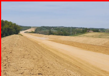
Vue du chantier
