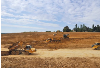
Les matériaux sont repris sur le stock à l'aide d'une pelle sur chenilles et de tombereaux articulés, puis mis en œuvre sur 40 cm par des bulls assistés par GPS
