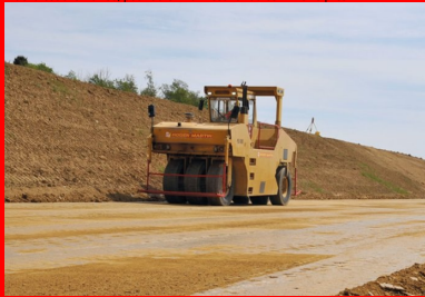
Un compacteur à pneus PS500 effectue le lissage pour donner un bel uni
