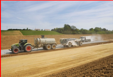
Épandage du LHR Rolac Premier à la surface du matériau (à l'aide d'un épandeur asservi avec contrôle pondéral) et malaxage du matériau du LHR par un malaxeur Wirtgen WR 240i avec injection d'eau dans la couche.
