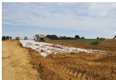
Après scarification et épandage de la chaux, le matériau est malaxé.
