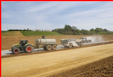
Épandage du LHR Rolac Premier à la surface du matériau (à l'aide d'un épandeur asservi avec contrôle pondéral) et malaxage du matériau du LHR par un malaxeur Wirtgen WR 240i avec injection d'eau dans la couche.
