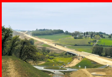
Vue d'ensemble d'un tronçon du chantier de contournement de Gimont. Il permettra de relier Toulouse à Auch, tout en évitant la ville.
