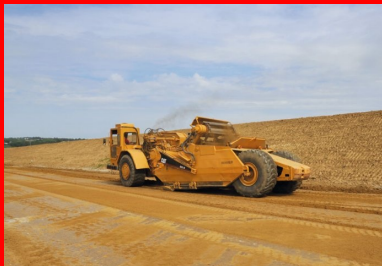
Une niveleuse assistée par théodolite motorisé effectue le réglage par recoupe de la couche traitée, pour obtenir un résultat au centimètre près
