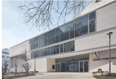
Sous le porte-à-faux créé par le retrait de la façade au rez-de-chaussée, une grande paroi vitrée invite à entrer.
