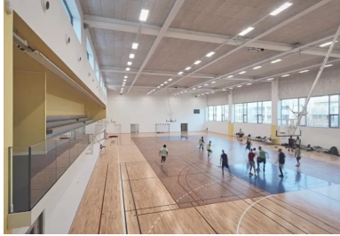
La toiture légère de la salle omnisports est portée par des poutres en béton reprises par des poteaux du côté de la façade sur la rue Ficatier et par une grande poutre-voile située au-dessus des gradins.
