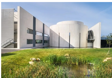
Les voiles courbes du hall et de l'auditorium, ainsi que les façades des laboratoires sont en béton autoplaçant blanc.
