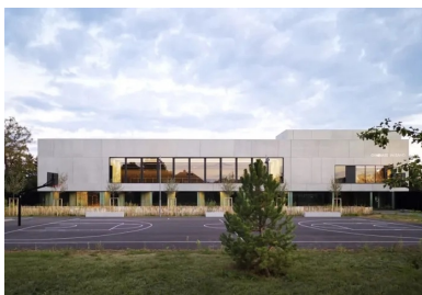
Le projet se caractérise par l'écriture minimale et épurée de sa géométrie orthogonale, façonnée et soulignée par les panneaux préfabriqués en béton gris au parement brut lisse de son enveloppe.
