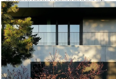
Le dessin des lignes horizontales et verticales des joints entre panneaux préfabriqués ainsi que de grandes ouvertures vitrées rythment les différentes façades.
