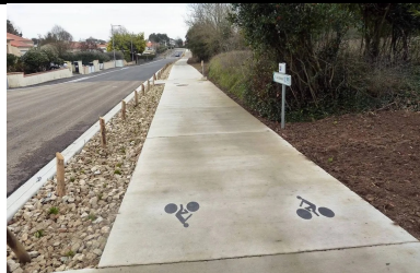
Piste cyclable en béton et retraitement en place au LHR pour un projet de requalification urbaine durable
