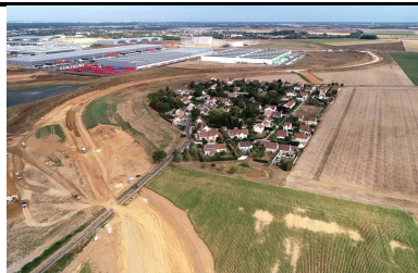
Une plate-forme support de chaussée innovante
