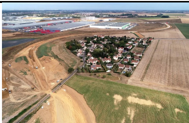
Une plate-forme support de chaussée innovante
