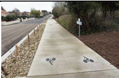
Piste cyclable en béton et retraitement en place au LHR pour un projet de requalification urbaine durable
