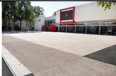
Orléans : deux belles réalisations en béton décoratif dans la cité de Jeanne d'Arc
