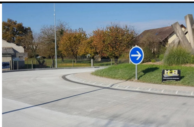
Durable et 100 % local, le premier giratoire en béton de référence de l'Isère
