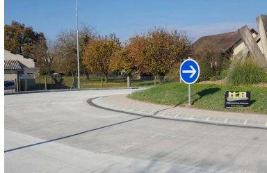
Durable et 100 % local, le premier giratoire en béton de référence de l'Isère
