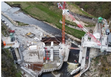
L'ouvrage en béton qui descend à droite est le nouvel exutoire de dévalaison situé en aval du barrage.
