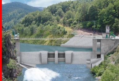
Photo-montage de l'ouvrage terminé. D'une hauteur de 7 m, le nouveau barrage est équipé de vannes amovibles qui seront ouvertes trois mois par an.
