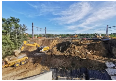
L'une des premières actions de l'opération coup de poing (OCP) a consisté à créer dans le remblai ferroviaire la brèche nécessaire à l'insertion du pont-rail. 13 000 m 3 de terre ont ainsi été déblayés en 24 heures.
