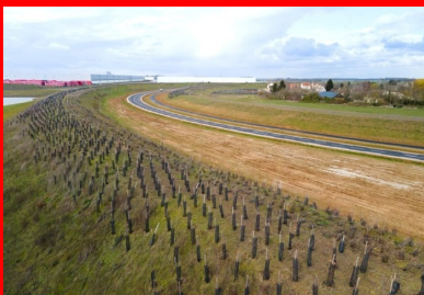
La nouvelle voie a été ouverte à la circulation en mars 2021. Ses aménagements paysagers permettent au nouveau tronçon de se fondre harmonieusement dans le paysage local.
