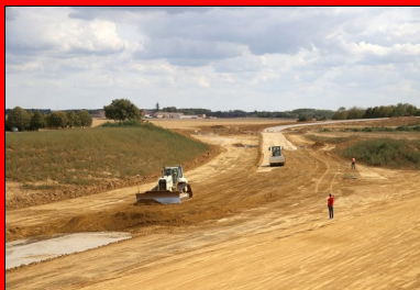
Réglage et compactage.
