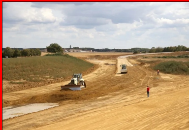
Réglage et compactage.
