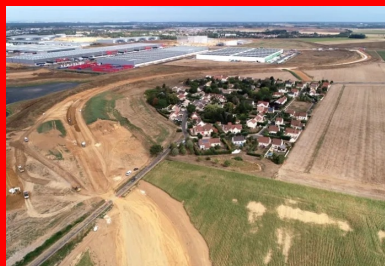
Vue aérienne du chantier du barreau sud de contournement du hameau d'Ourdy. Il permettra de relier les communes de Moissy-Cramayel et de Réau à Savigny-le-Temple.
