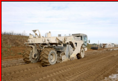
Le malaxage a été effectué à l'aide de la stabilisatrice Wirtgen 2400. Pour s'assurer de la bonne interface PST-CDF, 1-2 cm du traitement de la PST a été systématiquement repris.
