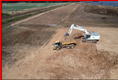
Les terrassements ont permis la réalisation d'un remblai « d'une hauteur de 7 m ».
