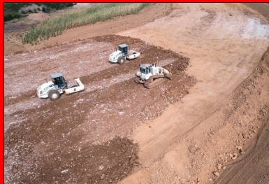
Vue d'ensemble des travaux de réalisation du remblai, par couches successives.
