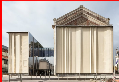
À l'opposé, le drapé de béton habille l'émergence de la cage de scène agrandie.
