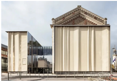
À l'opposé, le drapé de béton habille l'émergence de la cage de scène agrandie.
