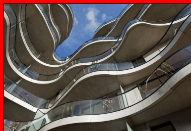
Présentée comme une « sixième façade », la sous-face des balcons en béton brut révèle leur mise en œuvre.
