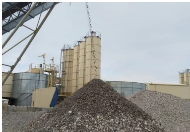
© SYSTRA (MOE) Les matériaux excavés sont triés avant d'être valorisés.
