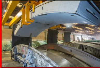
© ACTOPHOTO Après étuvage des moules pour accélérer la montée en résistance du béton, chaque pièce est démoulée à la ventouse.
