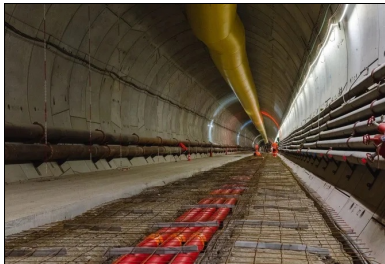
© SYTRAL (MOA) Coline, le tunnelier à pression de boue, creuse le tunnel avant de poser, voussoir après voussoir, les anneaux.
