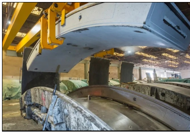
© ACTOPHOTO Après étuvage des moules pour accélérer la montée en résistance du béton, chaque pièce est démontée à la ventouse.
