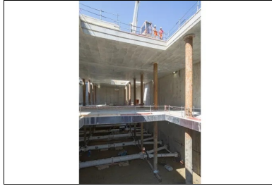
© ACTOPHOTO Utiles pour alimenter le chantier et évacuer les déblais, les trémies dispenseront la lumière naturelle dans les espaces souterrains. Les « préfondés » seront intégrés dans les poteaux ovoïdes de la station.
