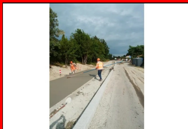
Balayage transversal du béton.
