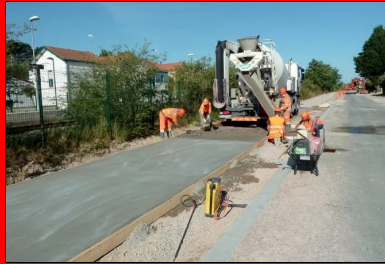
Coulage du béton.
