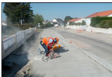
Exécution des joints de retrait par sciage.
