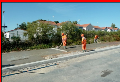
Vibration superficielle du béton.
