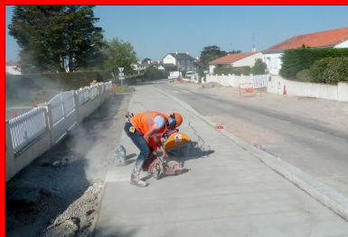
Excécution des joints de retrait par sciage.
