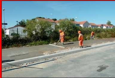
Vibration superficielle du béton.
