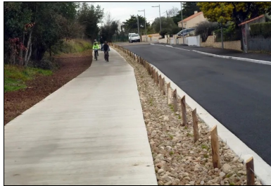
La noue sépare la piste cyclable de la chaussée rénovée.
