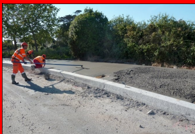
Talochage de la surface du béton.
