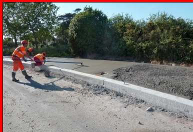
Talochage de la surface du béton.
