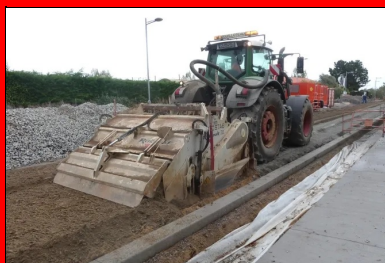
Après épandage du liant, le malaxeur mélange intimement le liant et les matériaux de l'ancienne chaussée.
