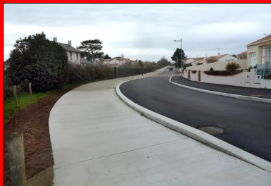
Vue de l'avenue Gilbert-Burlot avec le nouveau revêtement de chaussée.
