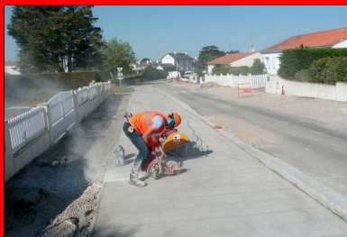
Excision des joints de retrait par sciage.
