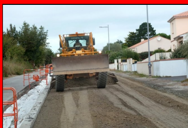
Réglage du matériau retraité à la niveleuse.
