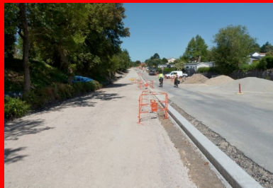
Après les travaux préparatoires de la piste cyclable, la bordure en béton - séparant la piste cyclable/moue de la chaussée - a été coulée en place à l'aide d'une machine à coffrages glissants.
