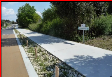
L'avenue Gilbert-Burlot a désormais une piste cyclable bidirectionnelle sécurisée par une noue et une chaussée recalibrée, renforcée et renouvelée. Le béton clair de la piste cyclable contraste visuellement avec la chaussée et rend plus lisible l'espace urbain.
