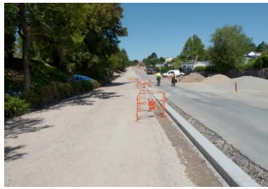
Après les travaux préparatoires de la piste cyclable, la bordure en béton - séparant la piste cyclable/noue de la chaussée - a été coulée en place à l'aide d'une machine à coffrages glissants.
