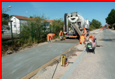
Coulage du béton.
