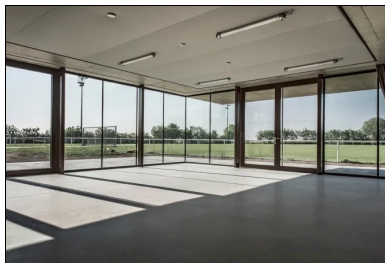
Vue sur le foyer. La dalle de plafond en béton coulé en place est revêtue d'une lasure incolore et intègre un traitement acoustique.
