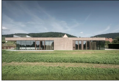
Les murs à coffrage et isolation intégrés (MCI) matricés des façades sont revêtus d'une lasure de teinte « terre », afin que le bâtiment s'intègre au mieux dans le paysage.
