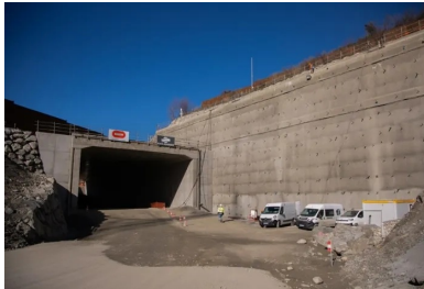
La tranchée couverte dégage une section libre de 18 m de large et 9 m de haut, dimensionnée pour accueillir deux voies ferrées à grande vitesse et tous les équipements du tunnel.
