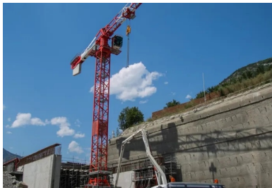
Pour contourner les difficultés d'accès, le béton est coulé par l'intermédiaire d'un camion-toupie équipé d'une pompe.
