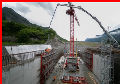
Coulage en cours de l'un des voiles latéraux de la tranchée couverte, dont l'épaisseur atteint 1 m.
