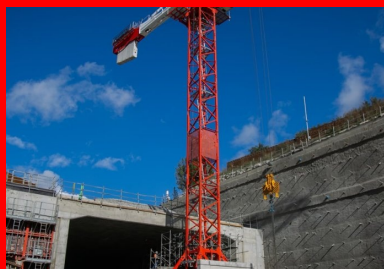
Pour résister à un éventuel recroisé dans le tunnel, le béton armé de la tranchée couverte ne dispose pas de protection au feu rapportée, mais d'une formulation spécifique : celle-ci intègre des fibres synthétiques en polypropylène qui, en fondant sous l'effet de la chaleur, libèrent des canaux connectés à l'intérieur du béton laissant la vapeur d'eau s'échapper, ce qui permet de maîtriser les risques de fissuration et d'écaillage du béton.
