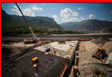
La construction de la tranchée couverte nécessite le déplacement puis le rétablissement de la RD1006 et de l'A43 (au fond).
