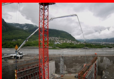
Le déploiement du bras de distribution articulé de la pompe à béton permet d'atteindre tous les points de coulage du chantier, même les plus difficilement accessibles, comme ici lors de la construction d'un voile latéral de l'ouvrage cadre.
