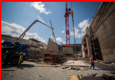
Le chantier de construction de la tranchée couverte (au centre) est réalisé à l'abri d'une paroi berlinoise (à droite).
