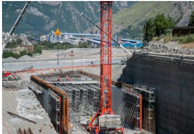
Les traverses supérieures de la tranchée couverte sont coulées en place à partir de tours d'étalement.
