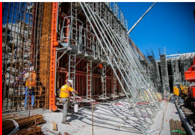
Préparation des banquettes métalliques nécessaires au coulage d'un voile latéral.
