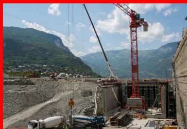
Les 9 000 m 3 des bétons de structure sont coulés en place. Le chantier dispose d'une centrale à béton principale située à Saint-Jean-de-Maurienne et d'une centrale de secours à Saint-Julien-Montdenis.
