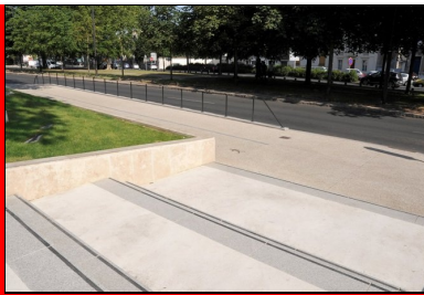
Au-delà du parvis, l'environnement immédiat du théâtre a également fait l'objet d'un réaménagement et d'un embellissement grâce au béton, notamment l'espace arboré dédié aux sculptures de l'artiste orléanais Roger Toulouse et la terrasse du restaurant attenant au théâtre.
