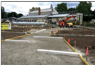
Les cheminements en béton du Jardin des plantes ont été réalisés en mars et avril 2019. Signe particulier : ils sont en béton blanc intégrant de gros granulats de calcaire local O/60 (Pontijou, près de Blois), avec une finition bouchardée.
