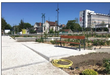
Les cheminements en béton du Jardin des plantes ont été réalisés en mars et avril 2019. Signe particulier : ils sont en béton blanc intégrant de gros granulats de calcaire local O/60 (Pontijou, près de Blois), avec une finition bouchardée.
