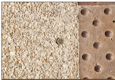
Trois finitions de surface et trois colorations sont mises en œuvre sur le parvis : béton sablé sur durcisseur charbon Viasol avec charge scintillante (quartz) pour les bandes sombres, béton imprimé « Empreinte pierre » sur durcisseur couleur sable pour l'effet roche brute et béton désactivé de couleur claire.
