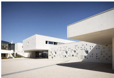
La façade principale en béton blanc est animée par un ensemble de perforations carrées, réparties de façon aléatoire.
