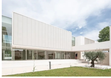
En continuité mais autonome, le nouveau bâtiment possède un caractère qui lui est propre. Son écriture architecturale est à la fois contemporaine et intemporelle.
