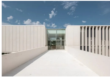
De grandes ventelles réalisées en béton blanc et préfabriquées protègent les surfaces vitrées de l'ensoleillement direct.
