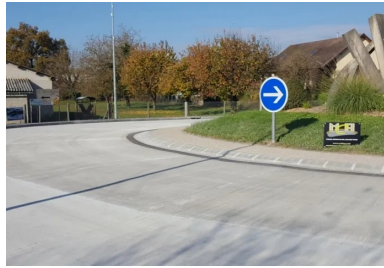
Le nouveau giratoire à trois branches situé à la sortie nord de Montalieu-Vercieu.
