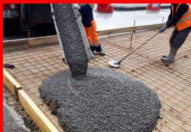
Réalisation des dalles de transition.
