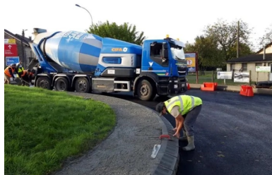
Le giratoire a été doté de nouvelles bordures dont les fondations ont été renforcées pour éviter les retournements.
