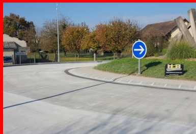
Le nouveau giratoire à trois branches situé à la sortie nord de Montalieu-Vercieu.
