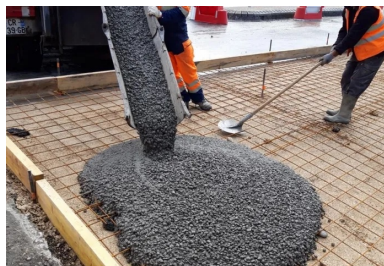
Réalisation des dalles de transition.
