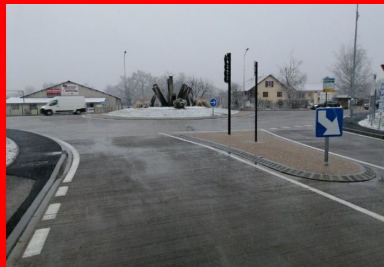
Le chantier du nouveau giratoire de Montalieu-Vercieu a pris fin le 16 novembre 2020, soit seulement deux semaines après la fin de la mise en œuvre du béton.
